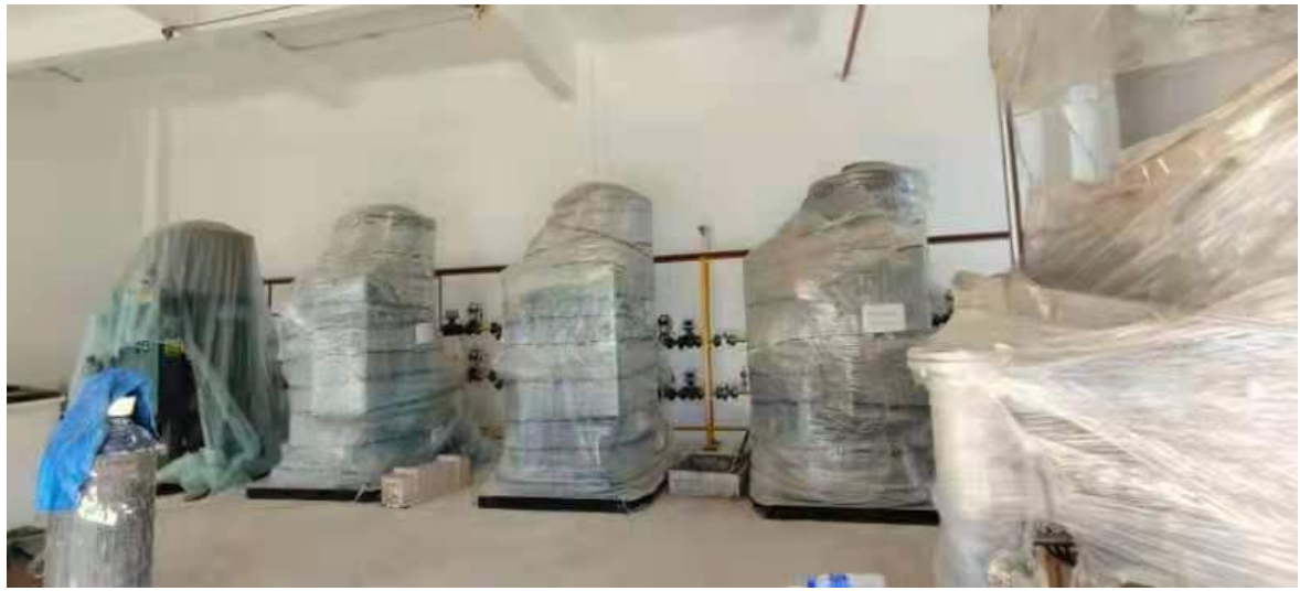
4 台 1t/h 蒸汽发生器（未安装）
